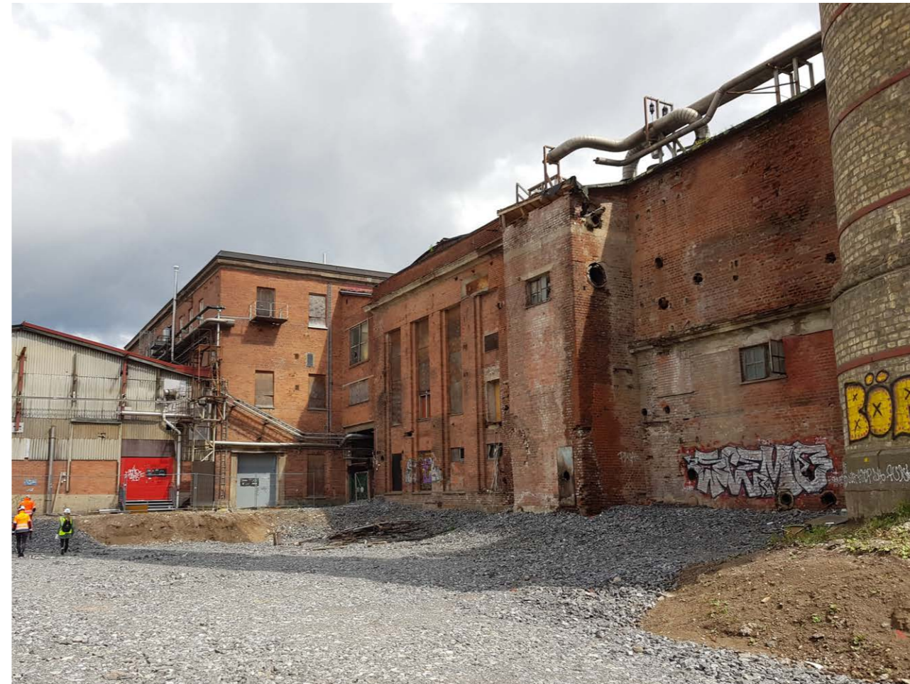
Voimalaitoksen alkuperäinen länsijulkisivu on tullut laajennusosien purkamisen myötä aiempaa paremmin esille. Harjakattoinen Tuotevarasto kuvan vasemmassa reunassa on tarkoitus purkaa.
